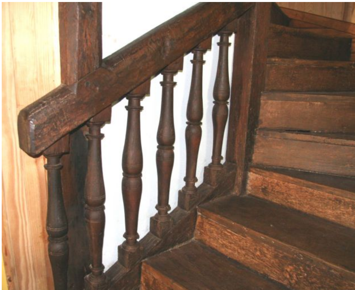
Escalier tournant en bois, détail : balustres symétriques.
