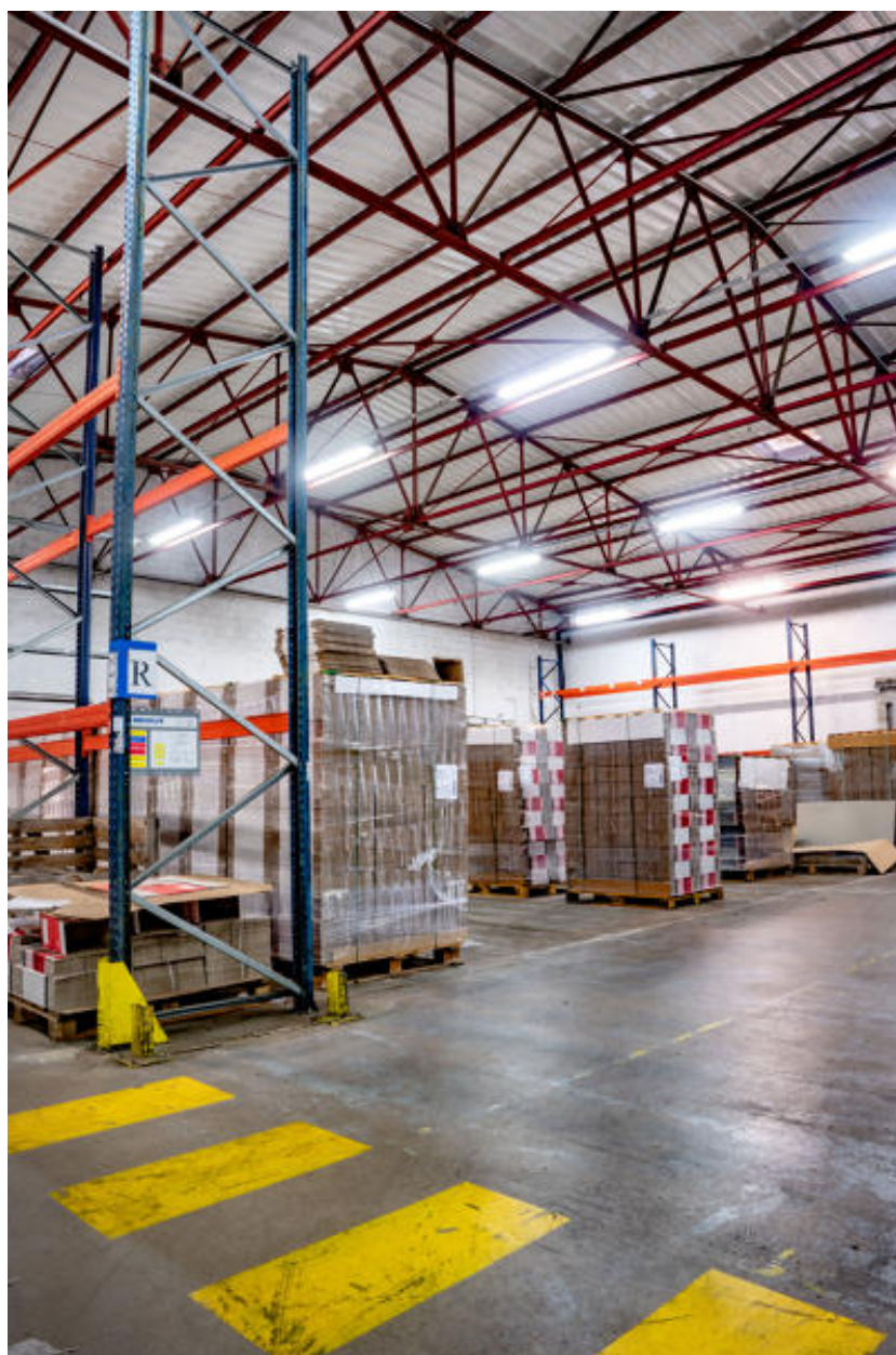
Entrepôt ouest et sa charpente métallique.
