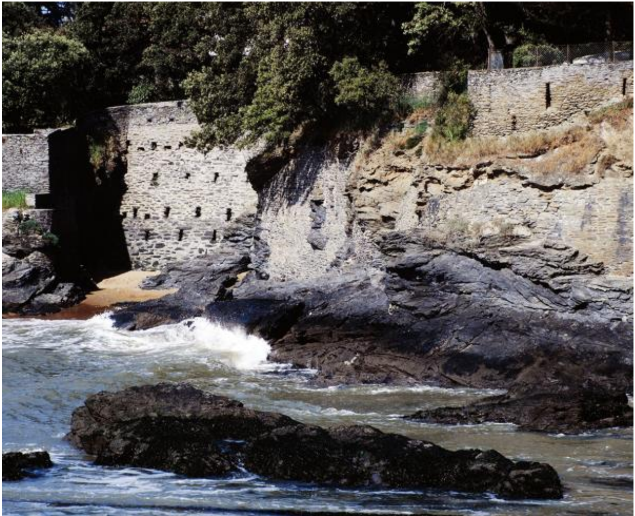
Mur de soutènement le long de la côte rocheuse.
