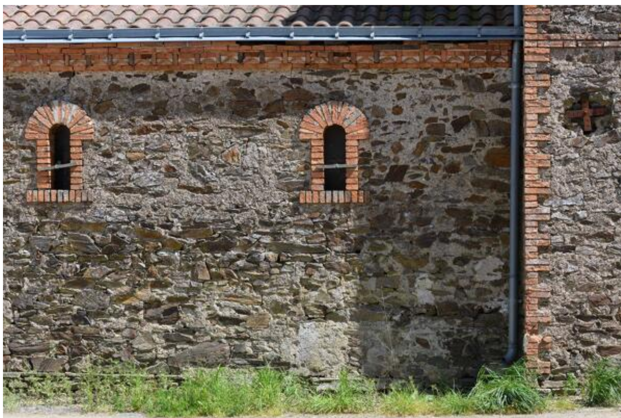
Façade ouest. Détail des jours de l'écurie.
