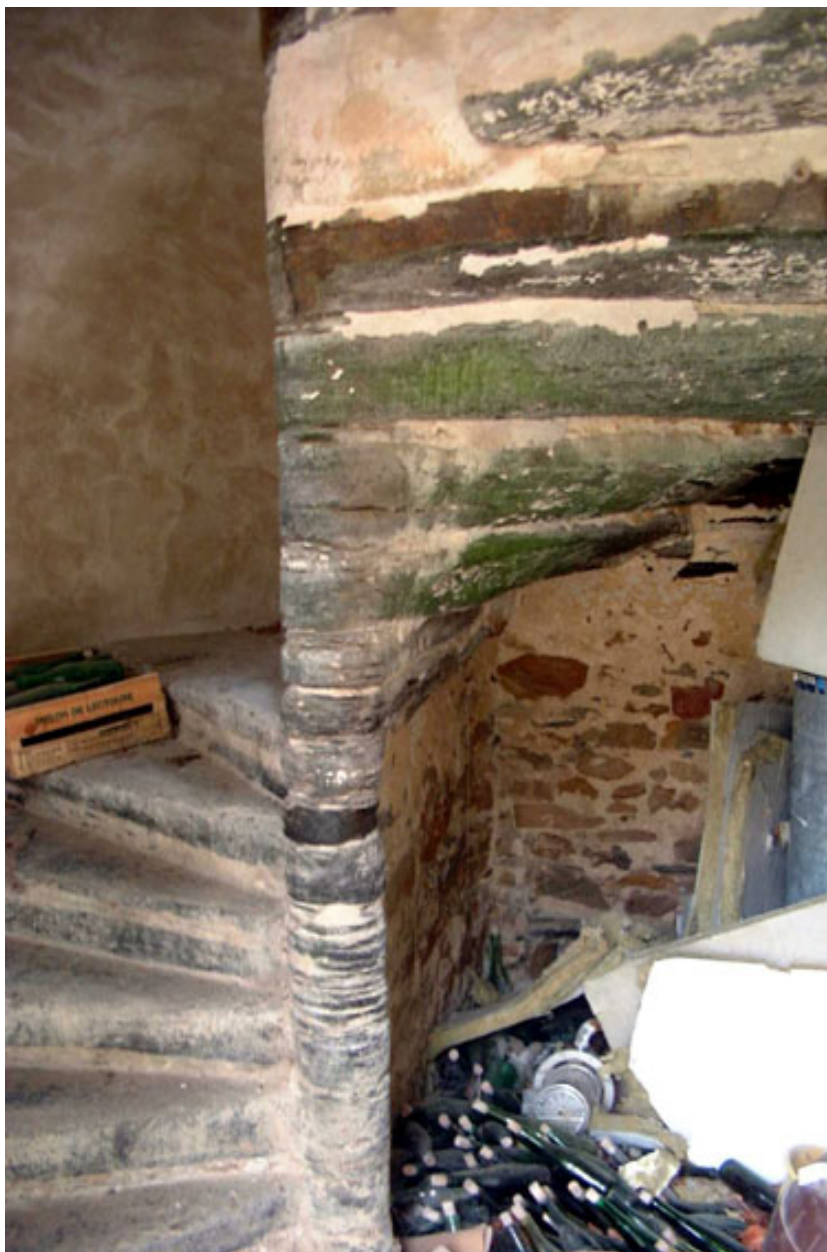
Tourelle d'escalier : marches en schiste.
