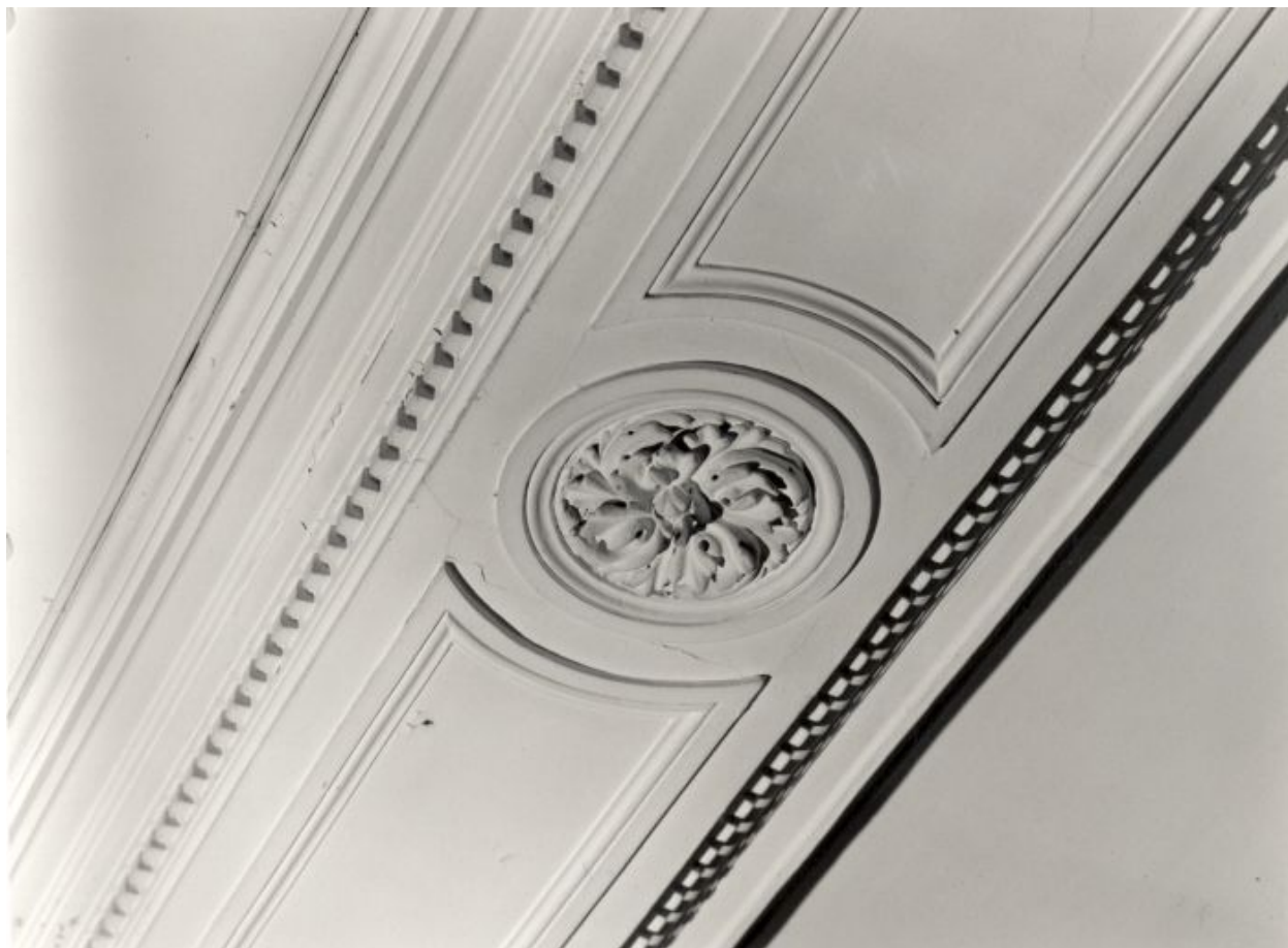
Salon, plafond : détail de la poutre.
