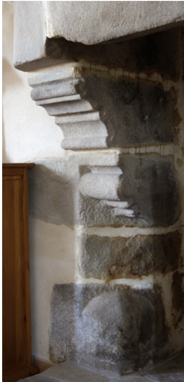
Logis. 1er niveau. Salle ouest. Détail du piédroit de la cheminée.
