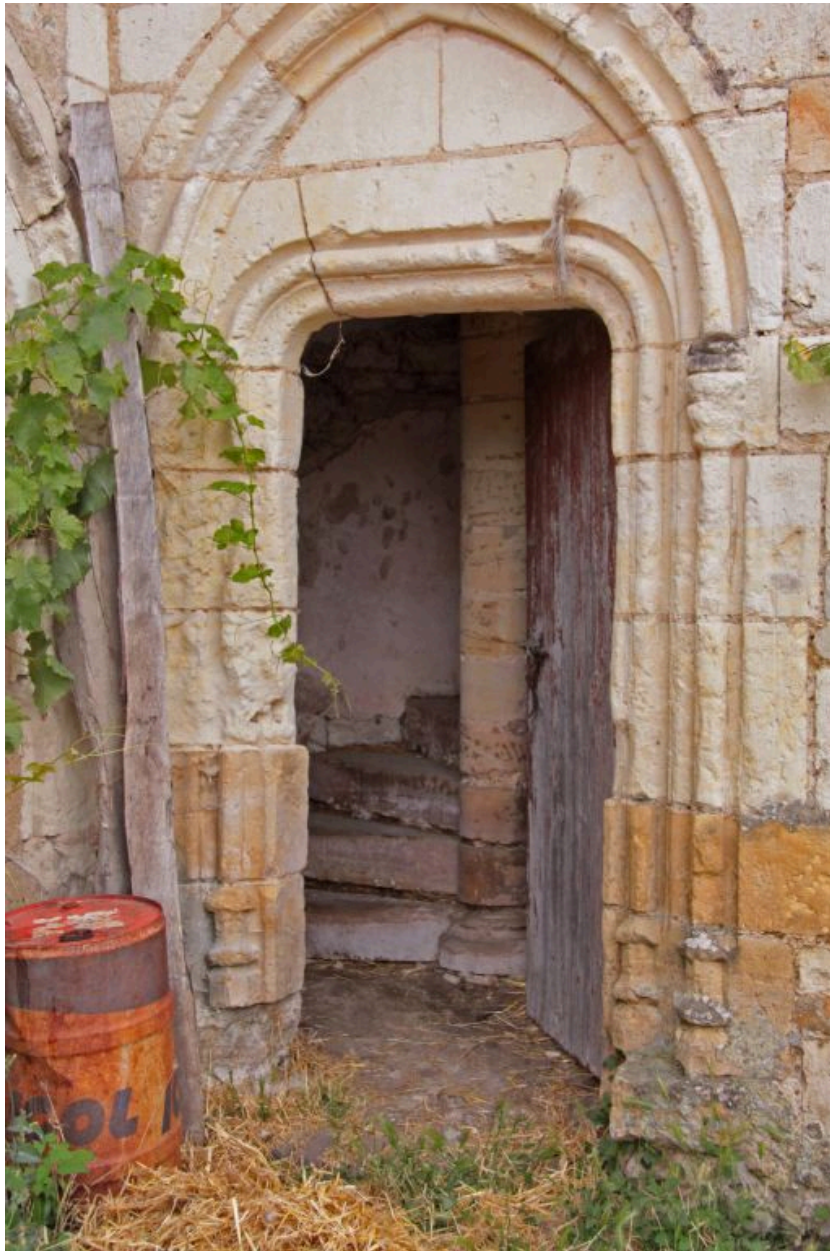
Tourelle d'escalier nord-ouest, détail : porte d'entrée et sas de distribution du rez-de-chaussée.
