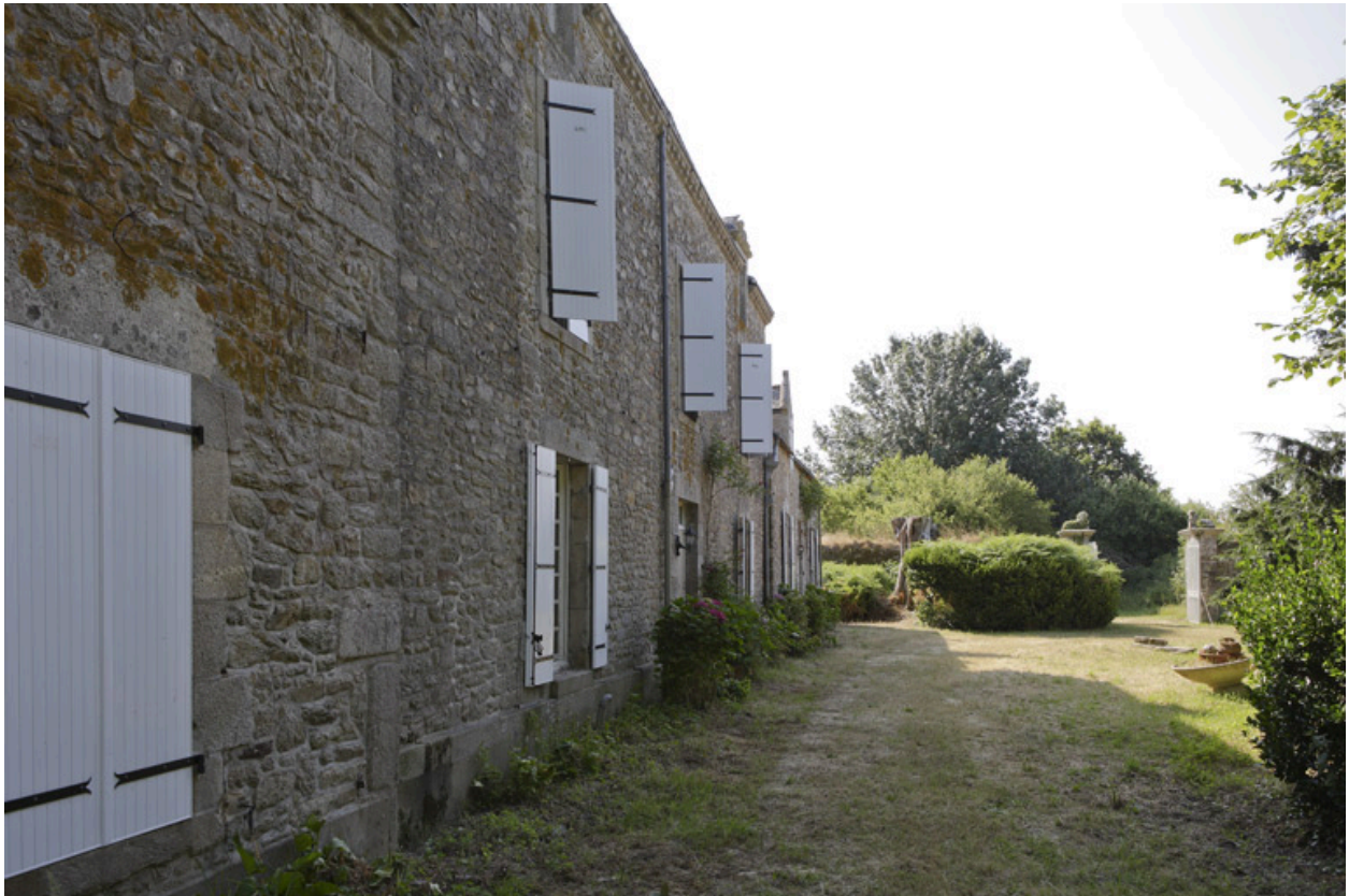
Logis. Façade est.
