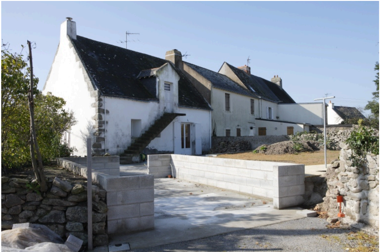
Vue de la façade nord de la rangée.
