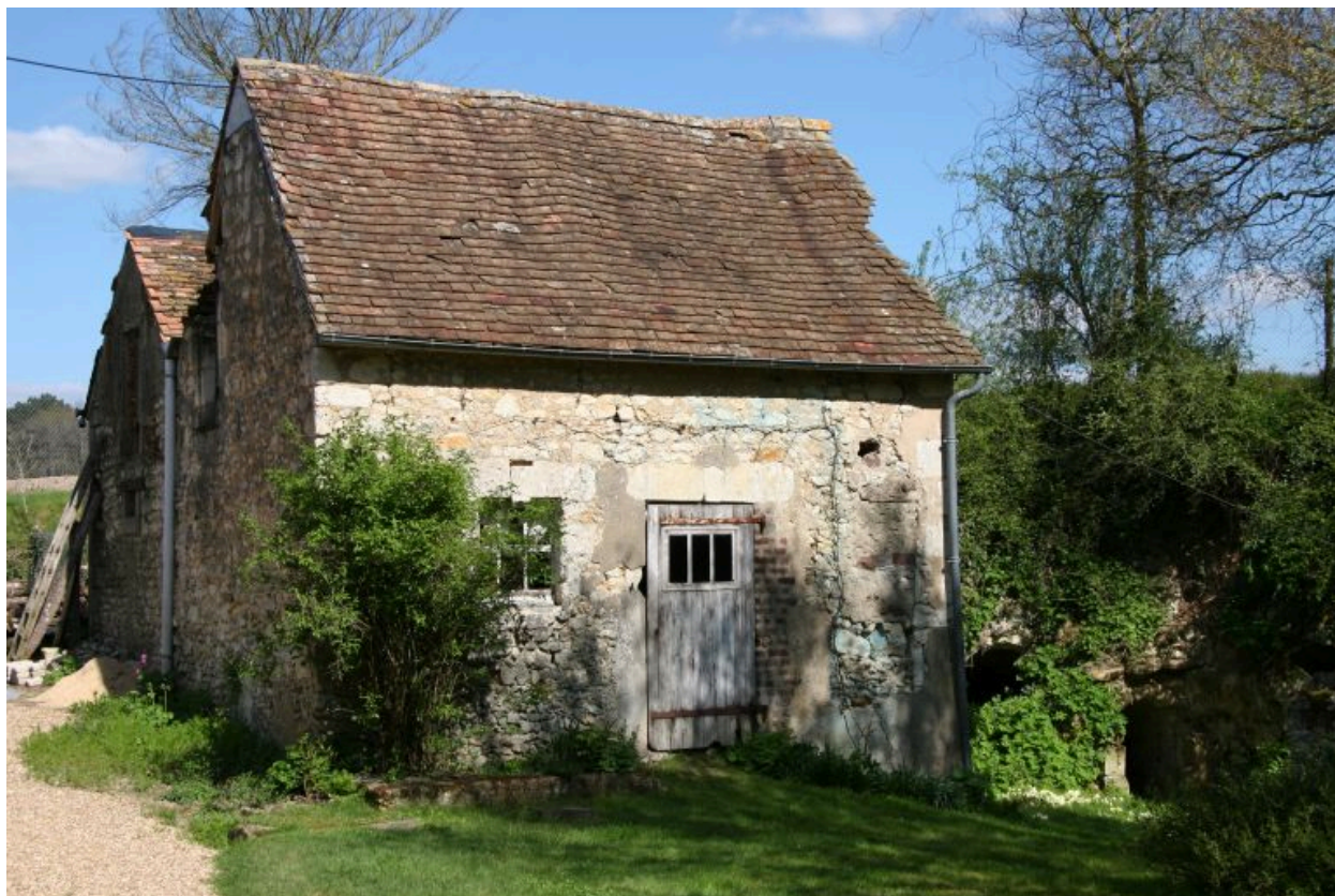
Buanderie avec toit à porcs adossé.
