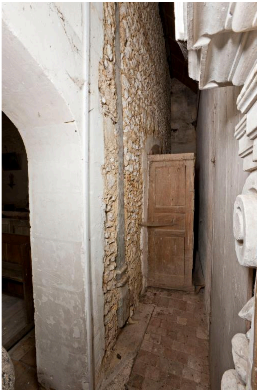
Nef : dédoublement du mur nord, vu depuis l'est.
