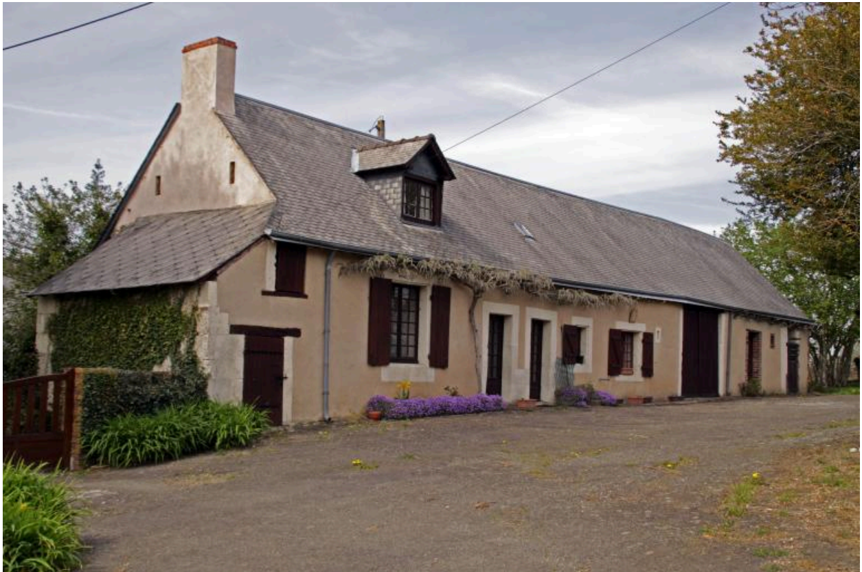
Ferme bloc à terre. La Hugerie.
