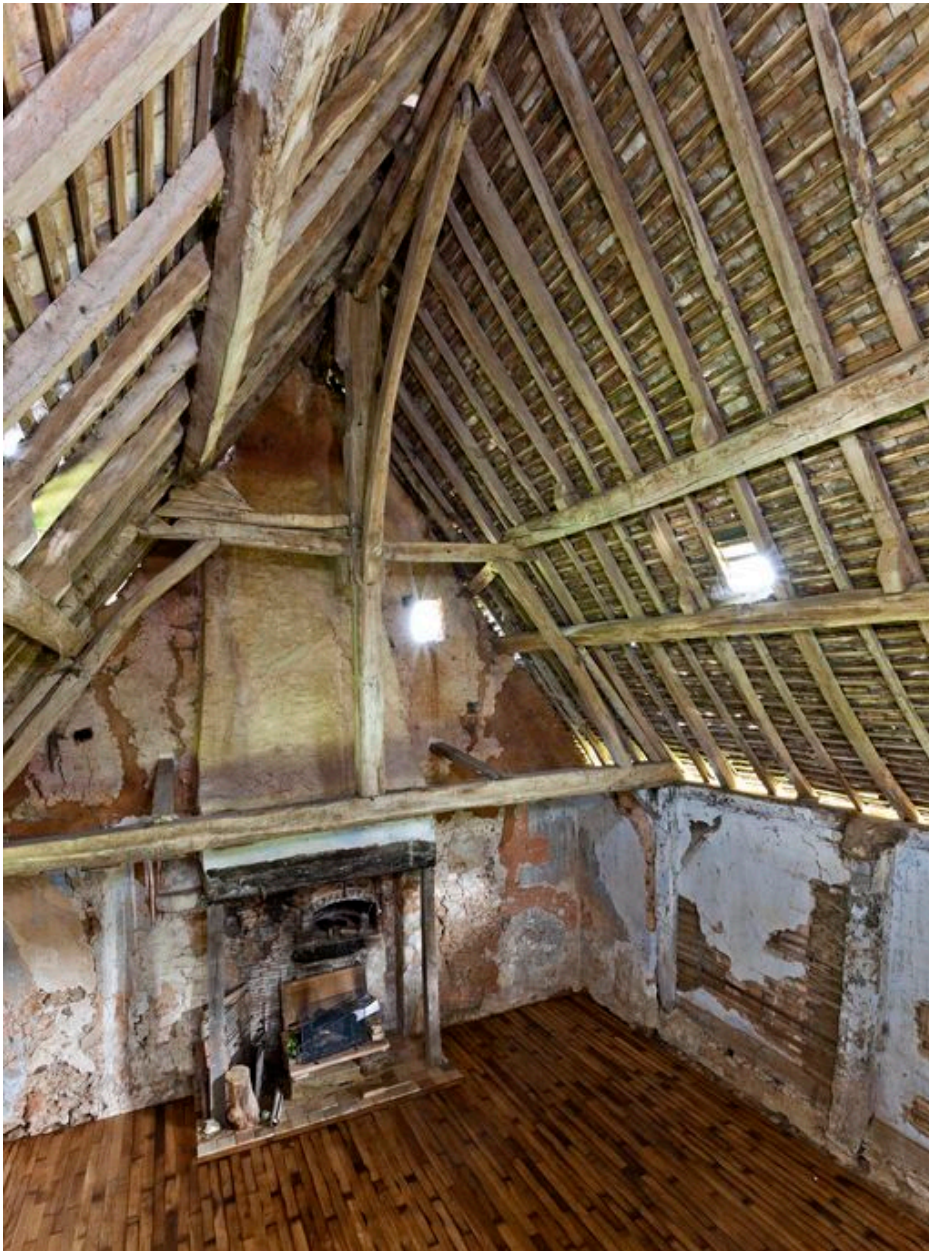
Vue intérieure du logis : pièce principale à cheminée.
