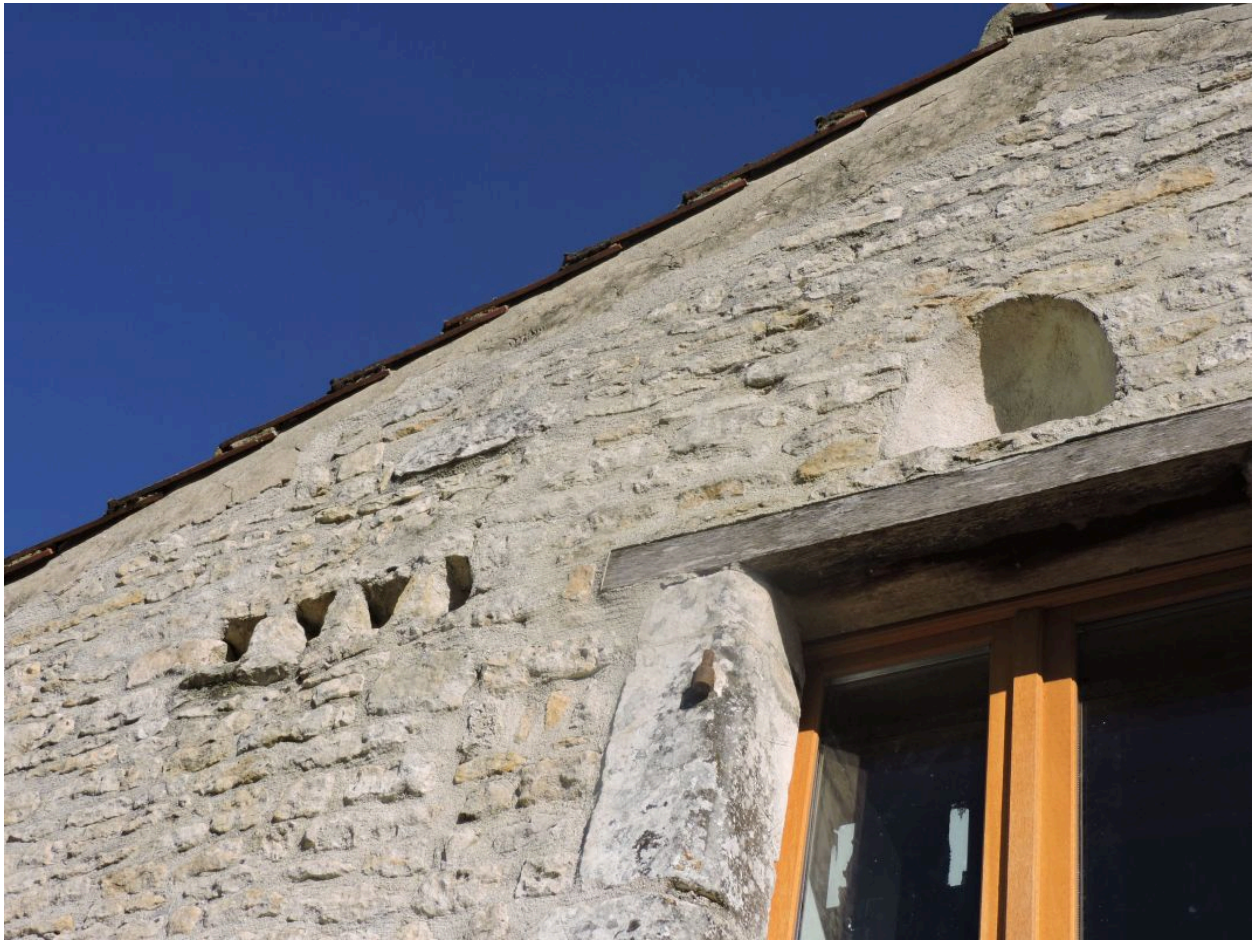
Les boulins à pigeons et la niche sur le mur pignon ouest.
