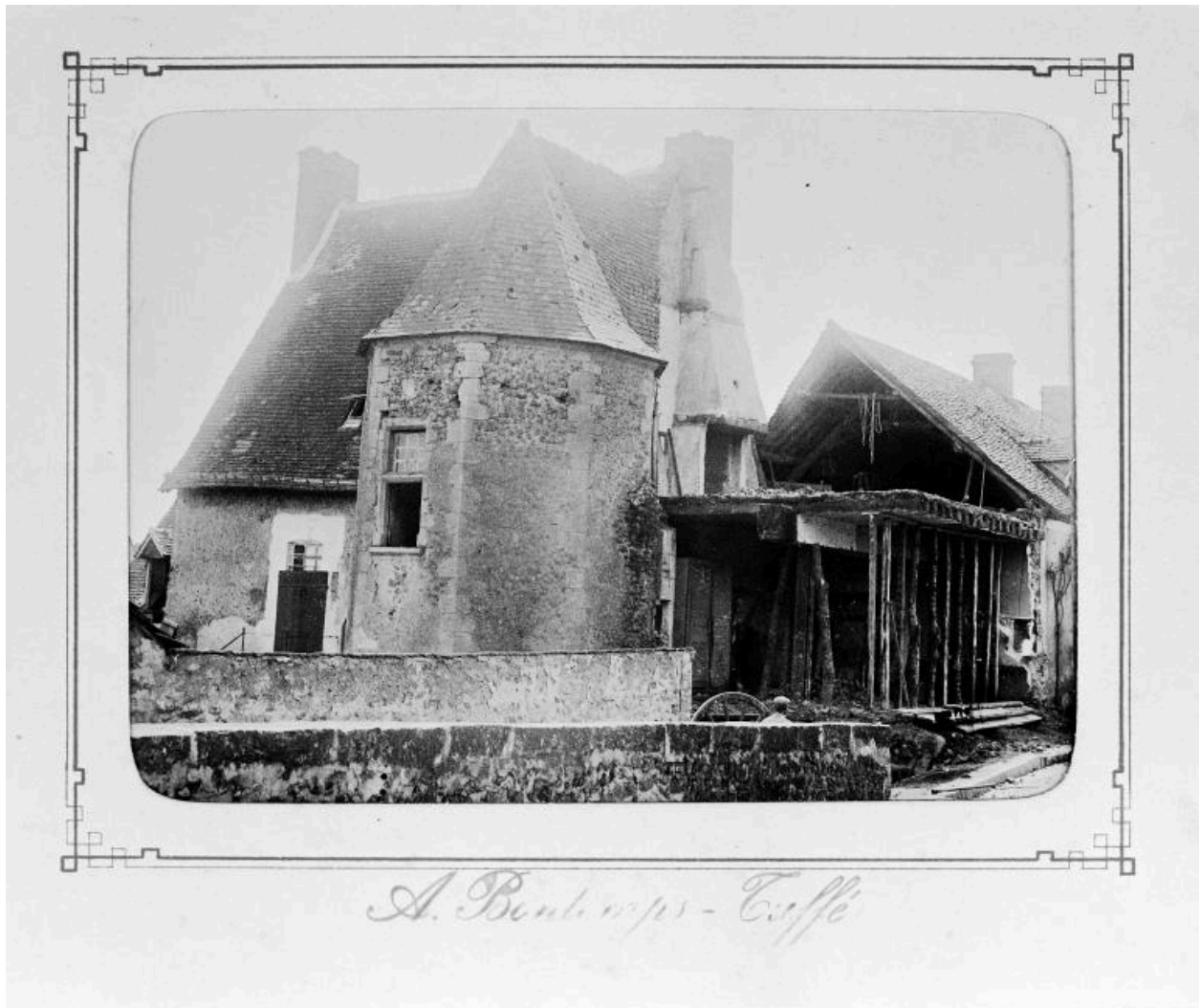
La démolition d'une portion du manoir, photographie de 1902.
