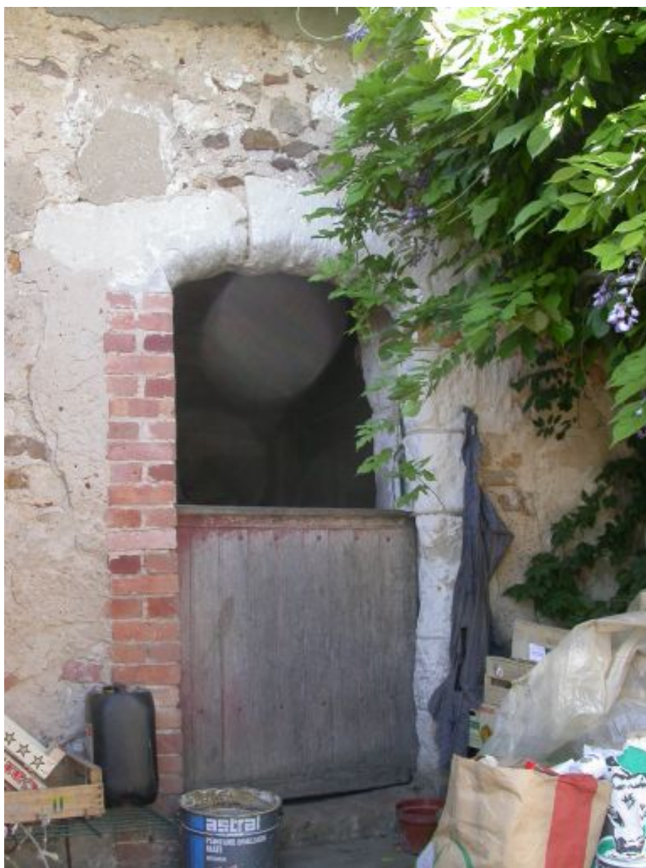
La maison, salle à gauche : porte d'entrée XVIe ou XVIIe siècle restaurée en brique.
