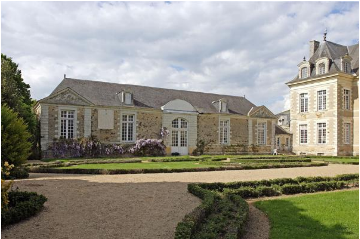
L'aile de communs nord, élévation antérieure.
