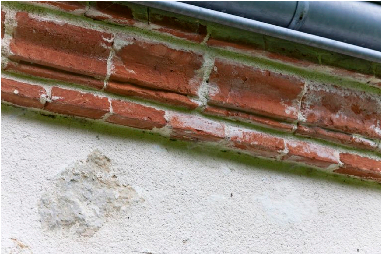
Détail de la corniche du logis.
