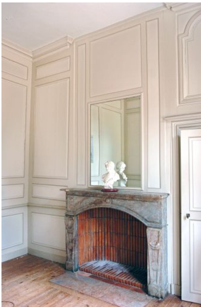
Le logis, aile ouest, 1er étage : chambre 1.
