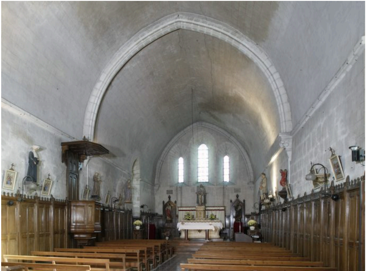
Vue intérieure de la chapelle prise de l'entrée en 2006, avant restauration.
