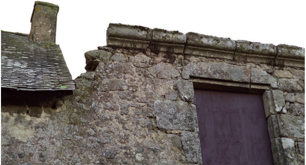
Corps central, façade occidentale, portion nord, détail de la corniche.
