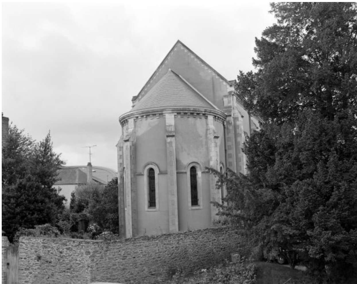
Abside : vue d'ensemble.
