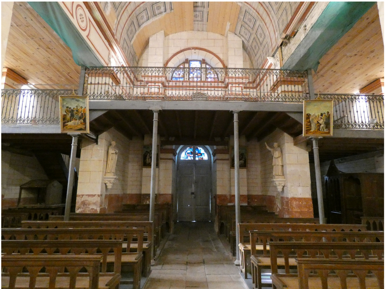
L'entrée ouest et la tribune vues depuis l'est.
