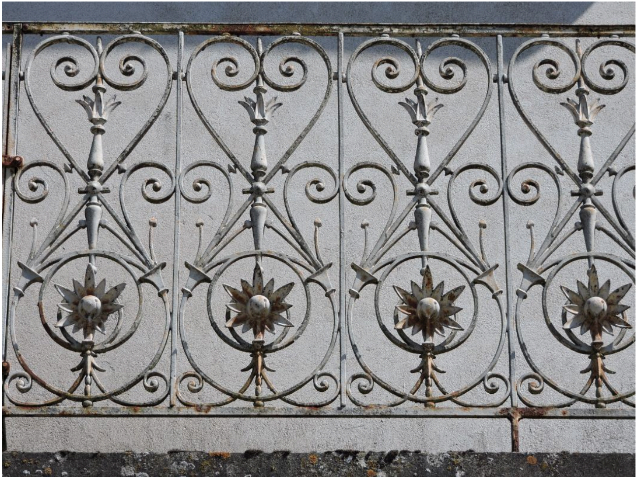
Détail du balcon au-dessus du passage couvert : fleurs.
