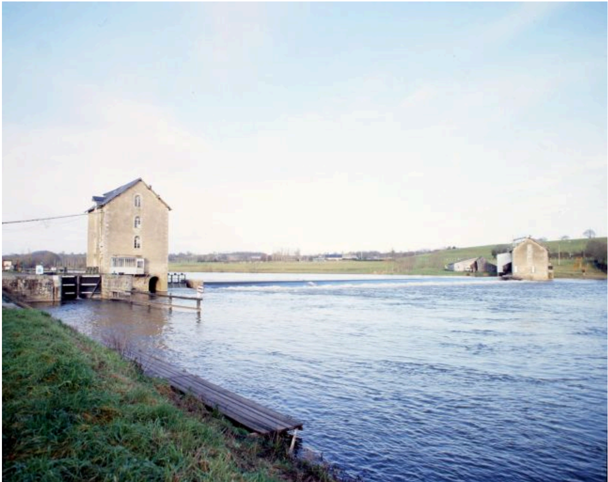
Vue d'ensemble du site depuis le chemin de halage, sur la rive droite, en aval, en 2002 : écluse, moulin de la Petite Bavouze, pertuis, barrage, moulin de la Grande Bavouze.
