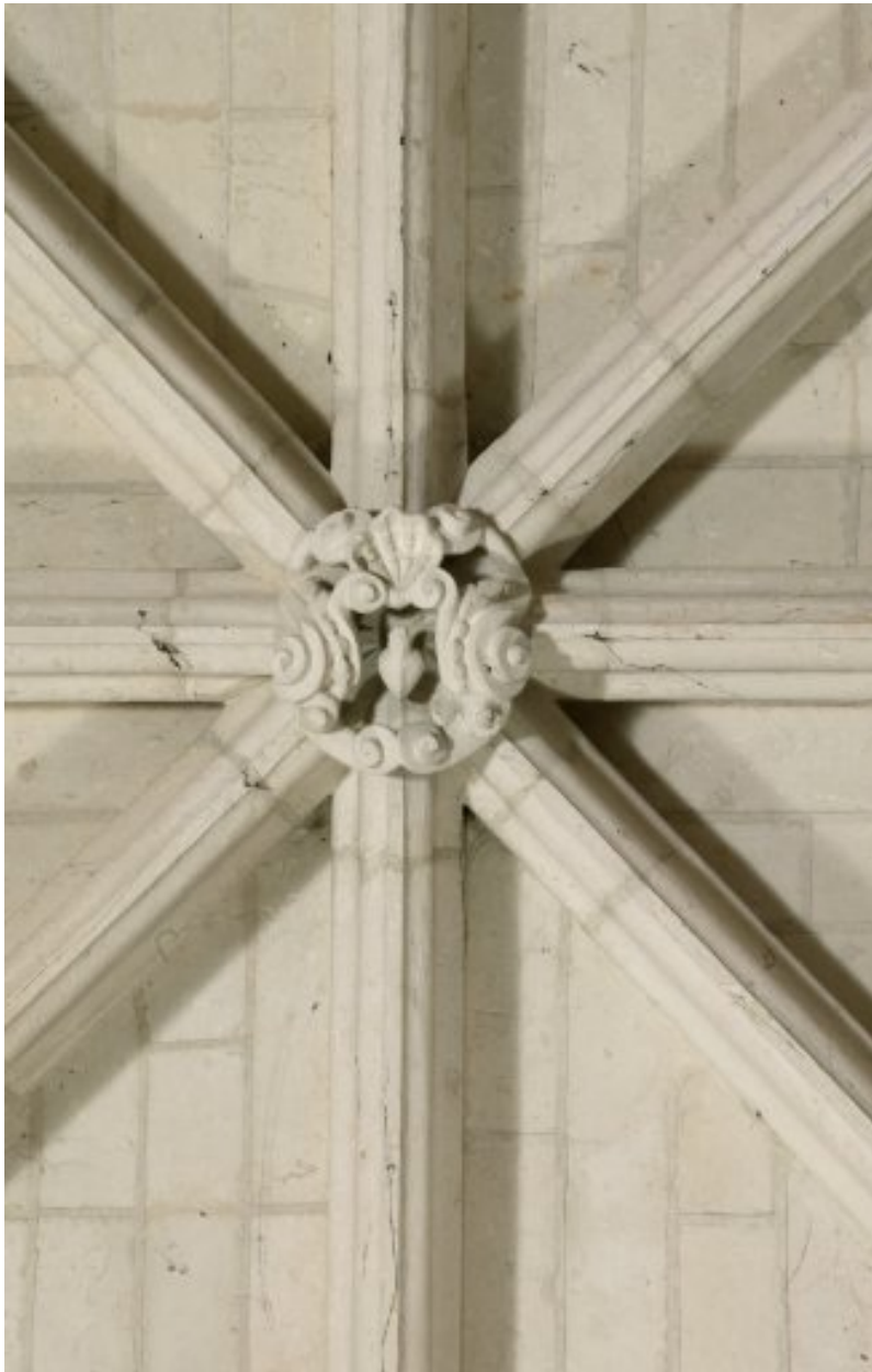
Rez-de-chaussée du massif occidental : clef de voûte de la travée nord, avec un coeur.
