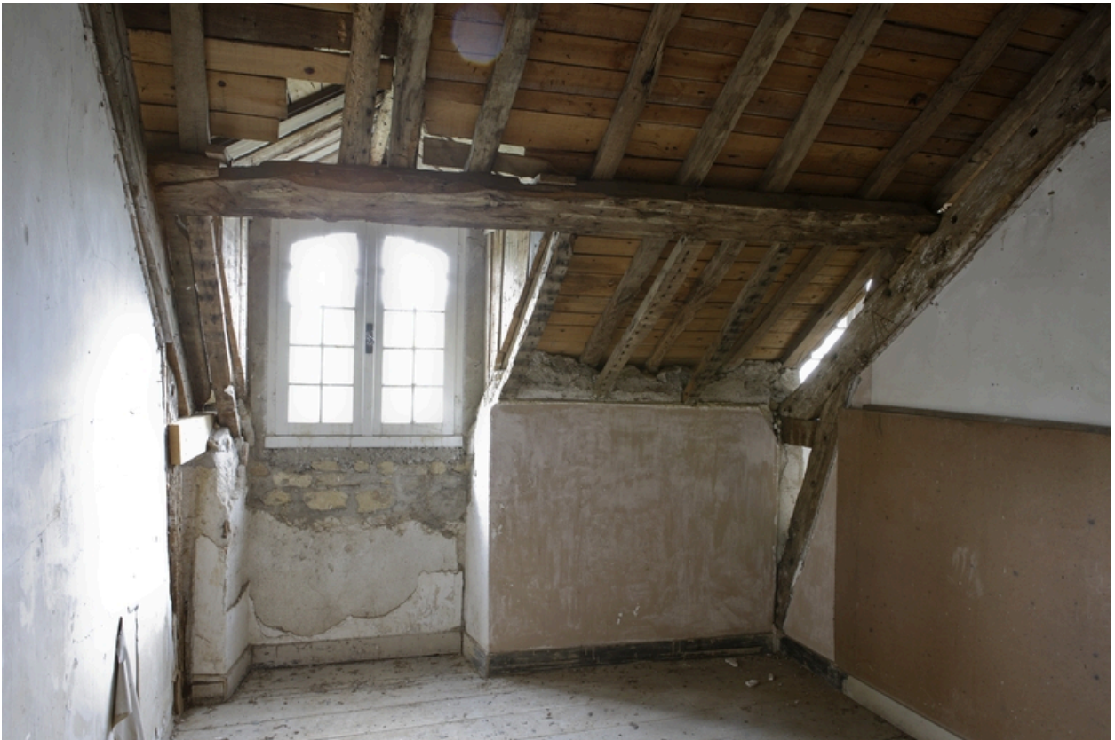
Logis. Aile nord. Étage de comble. Intérieure d'une lucarne.
