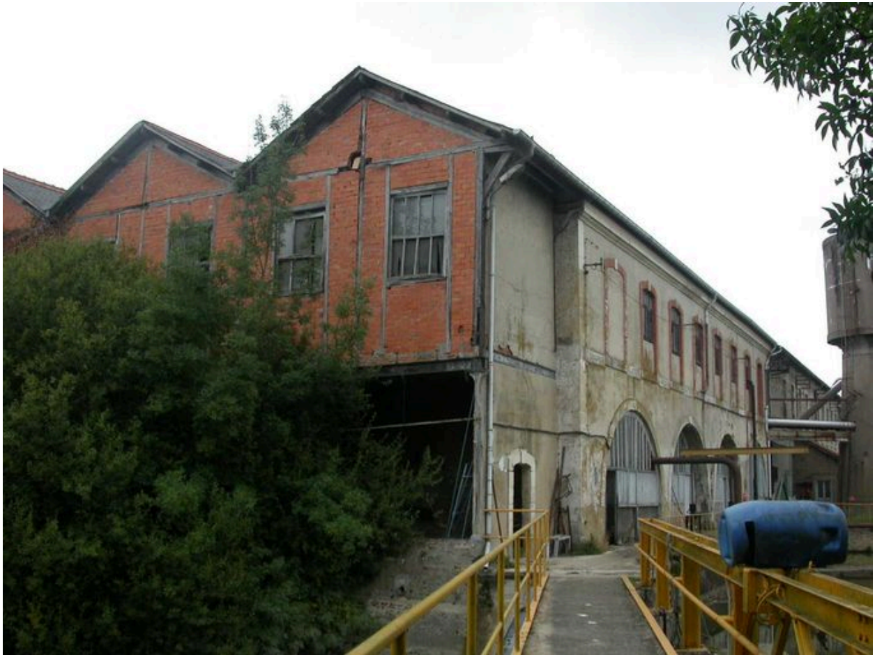
Élévation postérieure de la papeterie.
