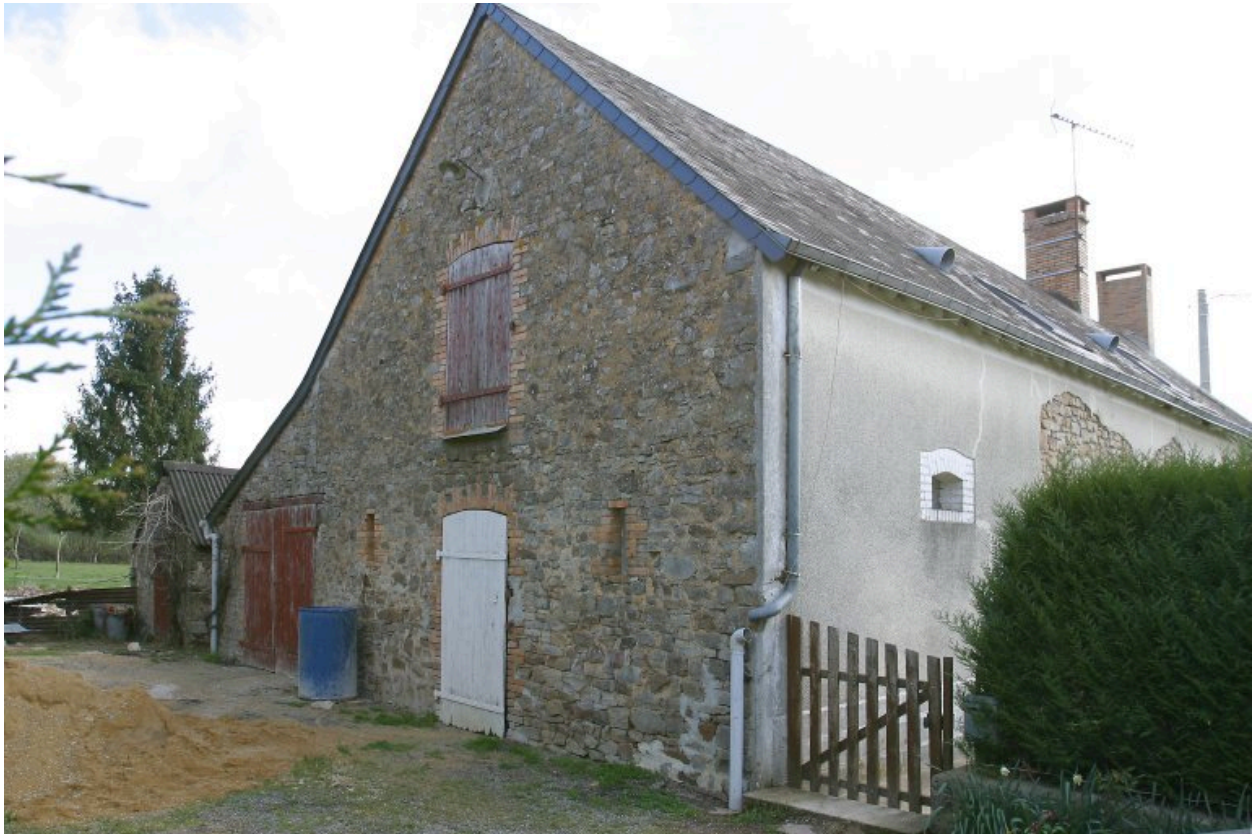
Vue de l'ouest.
