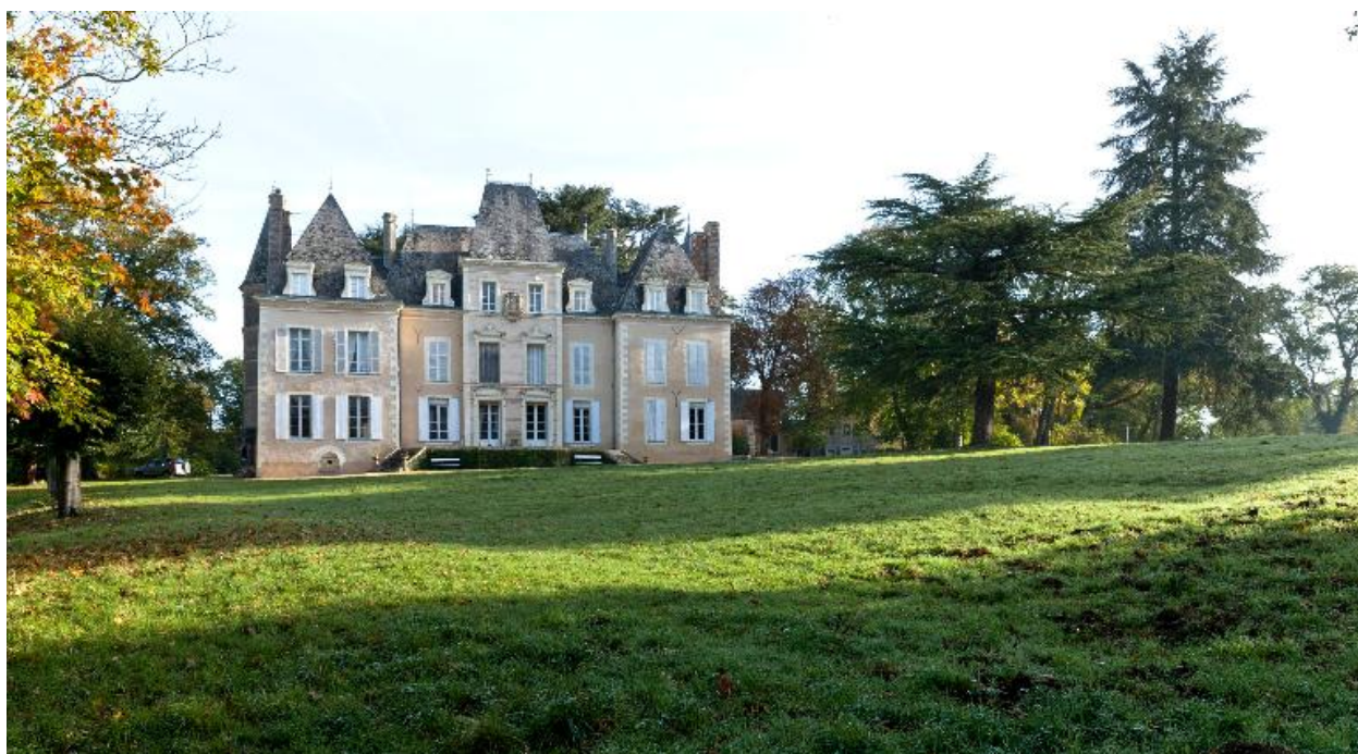
Vue d'ensemble du jardin et du château depuis le sud-ouest : l'élévation postérieure.
