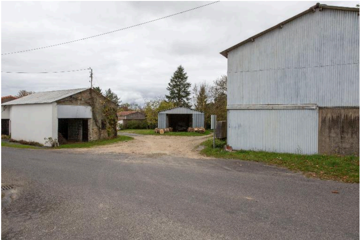
Hangars construits au XXe siècle sur l'espace commun. Cadastre 2014, BN-201.
