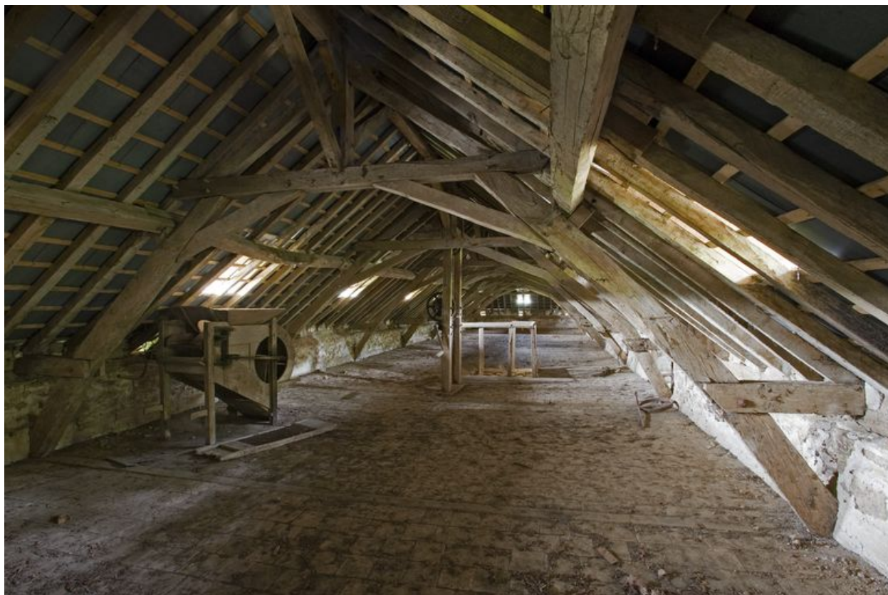
Ecurie-grange : vue d'ensemble du comble.
