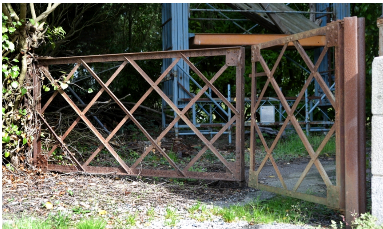
Barrières d'accès aux quais.
