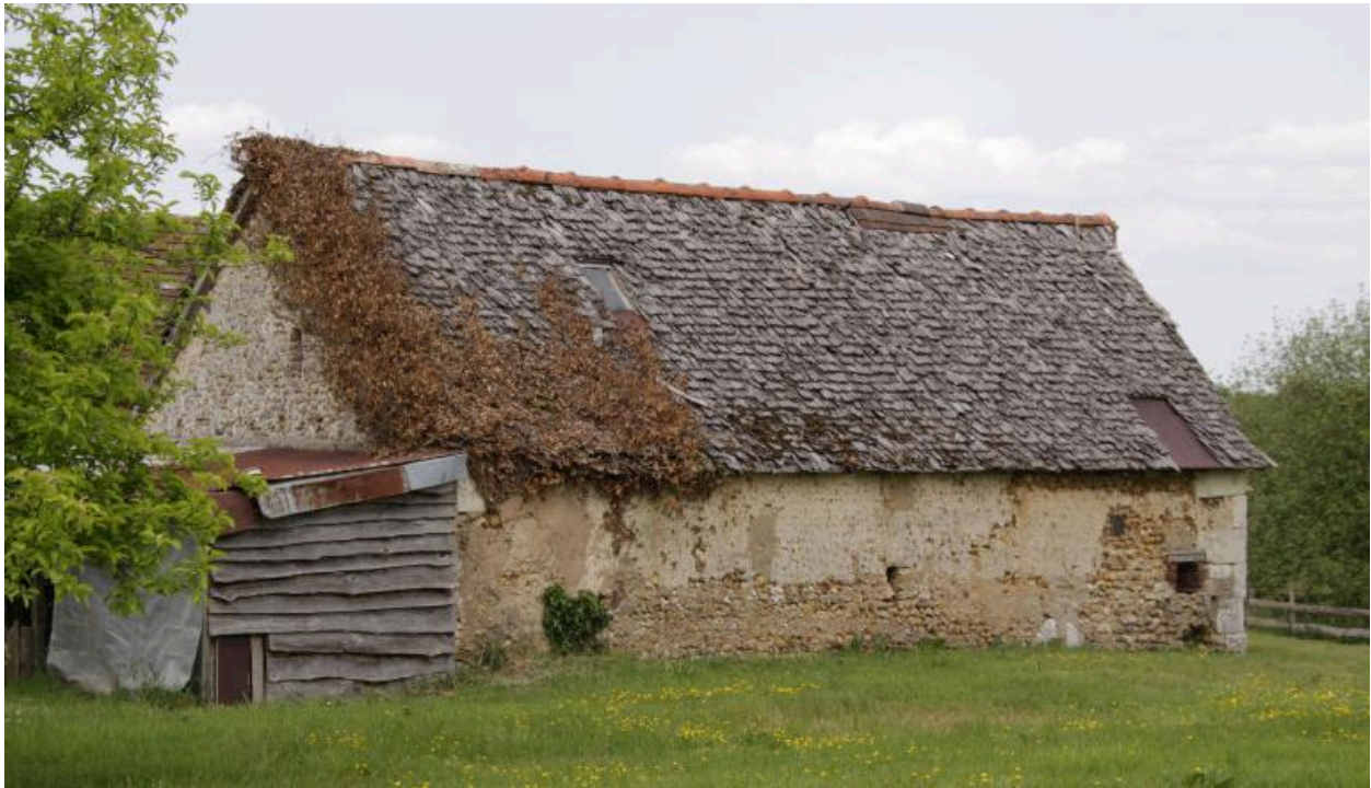
Dépendance face aux maisons : façade postérieure. Toiture en bardeaux de bois.
