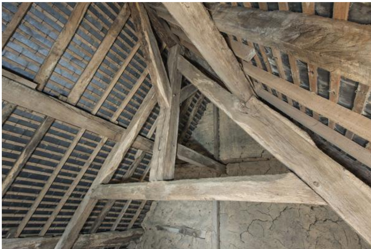
Ferme sud de la charpente.
