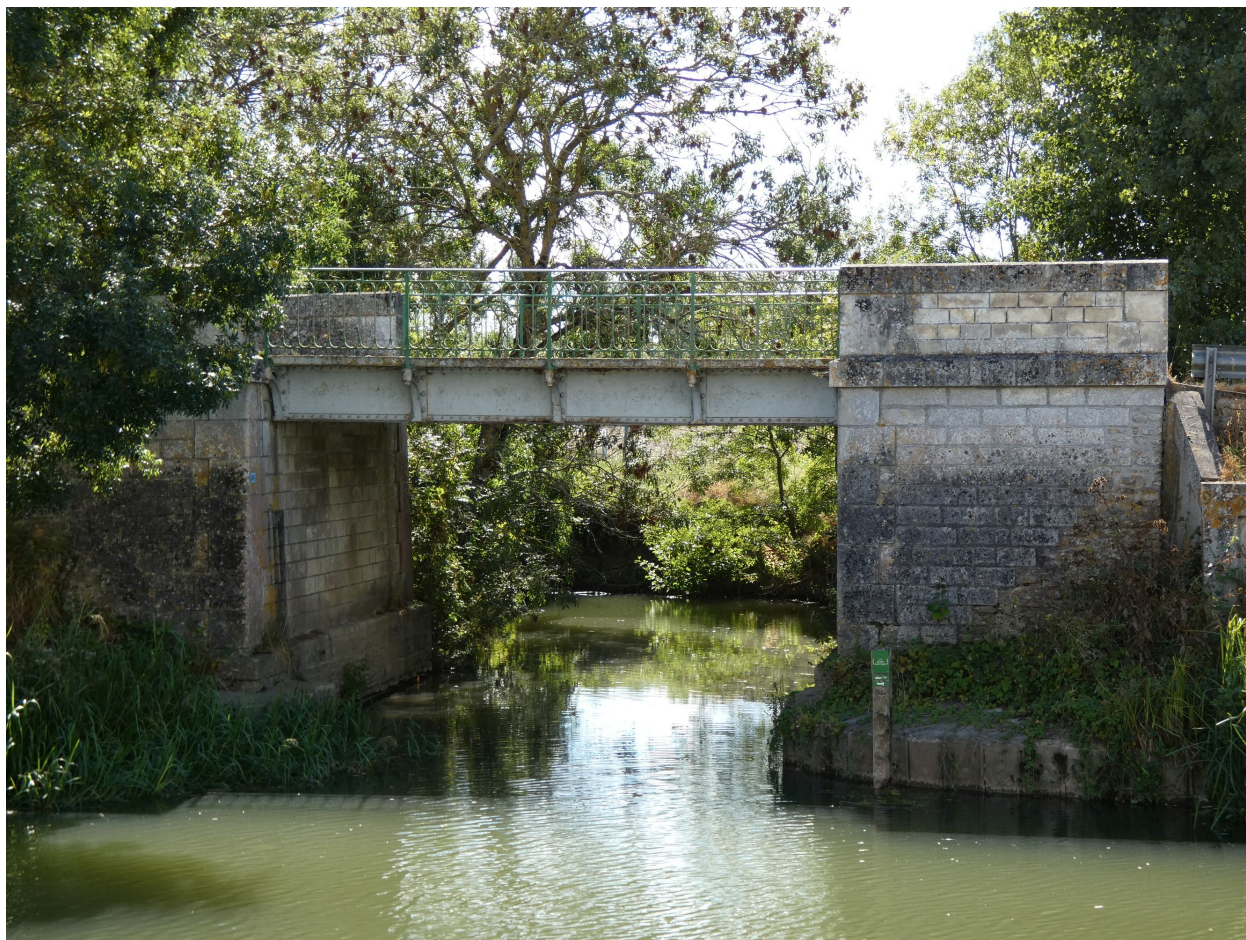
Le pont vu depuis la rive opposée de la Sèvre Niortaise, au nord.
