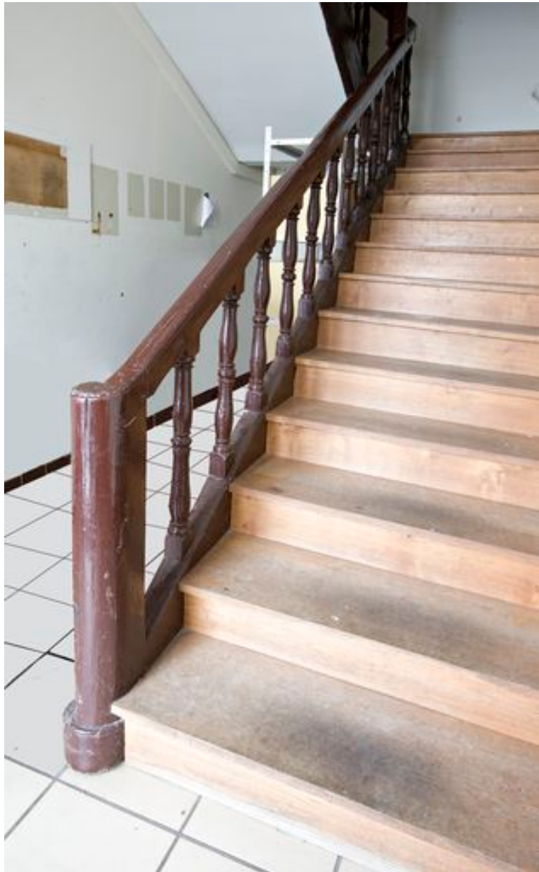
Escalier de la maison 65, rue du Port.
