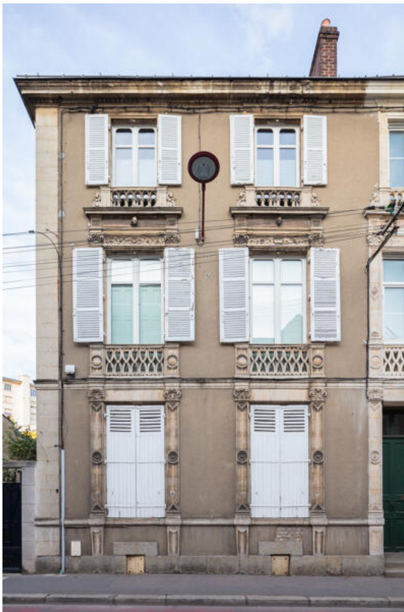
Vue des deux travées nord de la maison.
