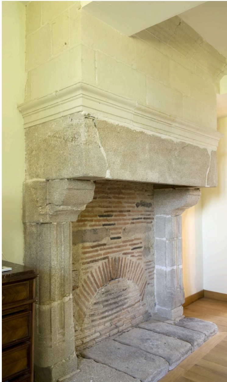
Pavillon. Rez-de-chaussée. Salle nord.
