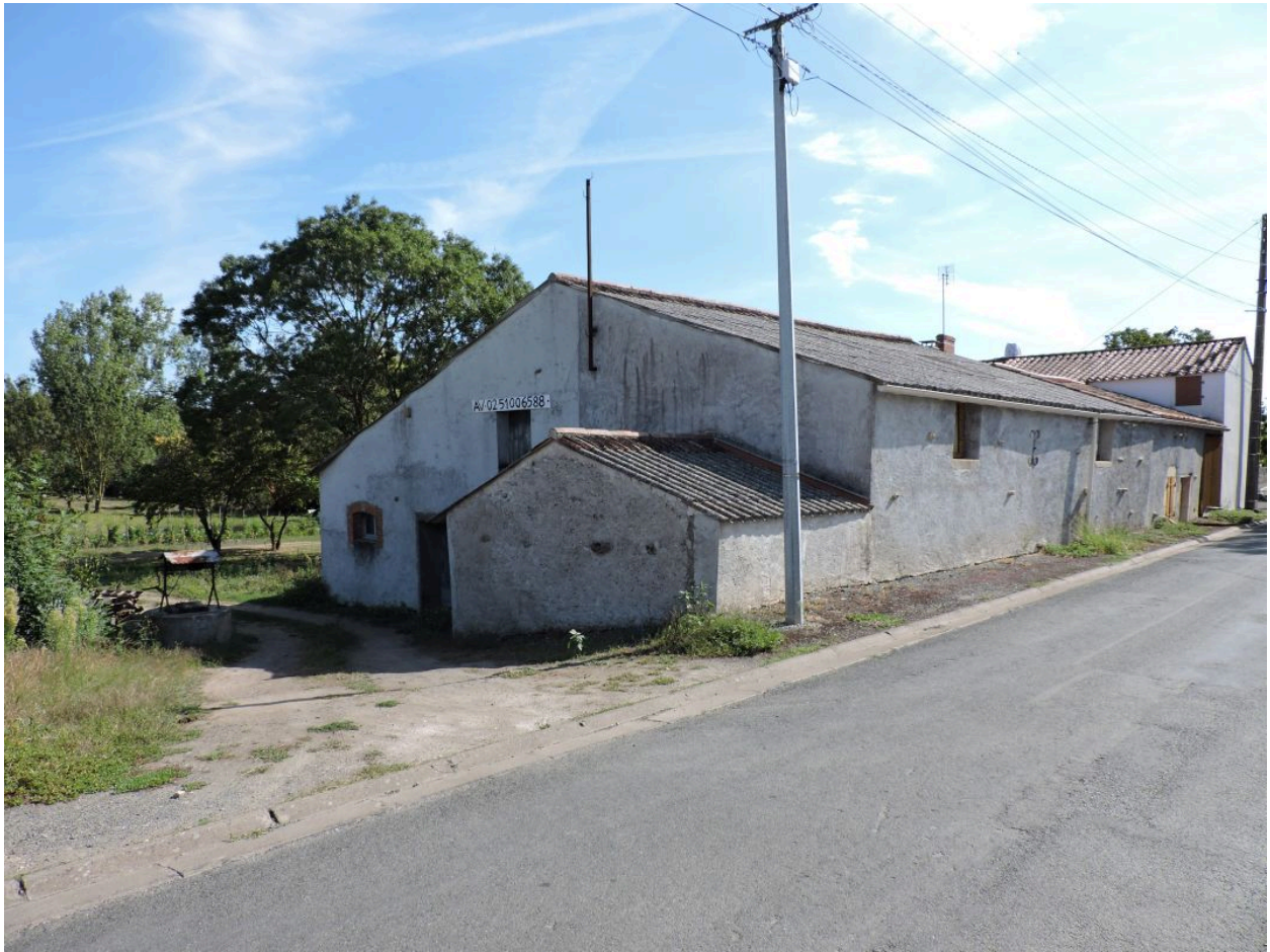
La grange-étable à façade en pignon vue depuis l'ouest.
