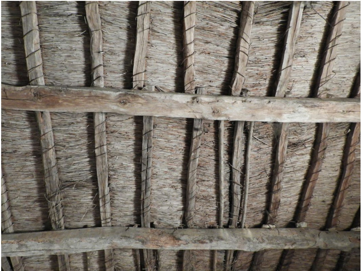
Le toit en roseau.
