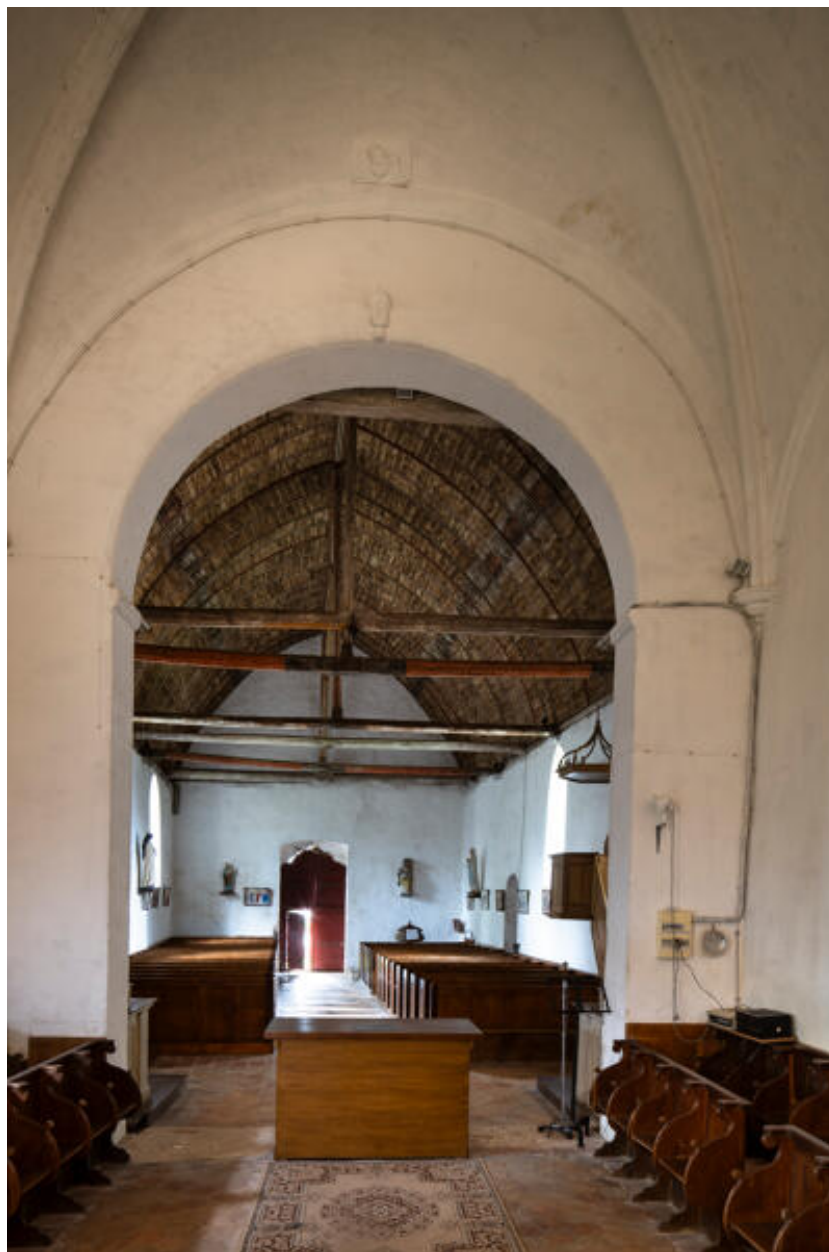
Première travée du choeur et nef.
