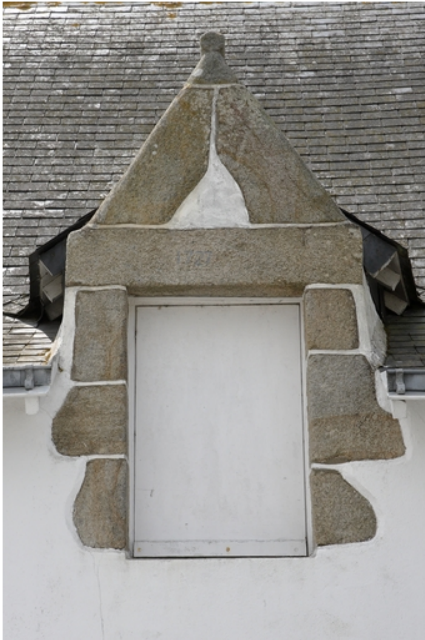
Détail de la lucarne datée 1727 (n°4 rue de l'Aire).
