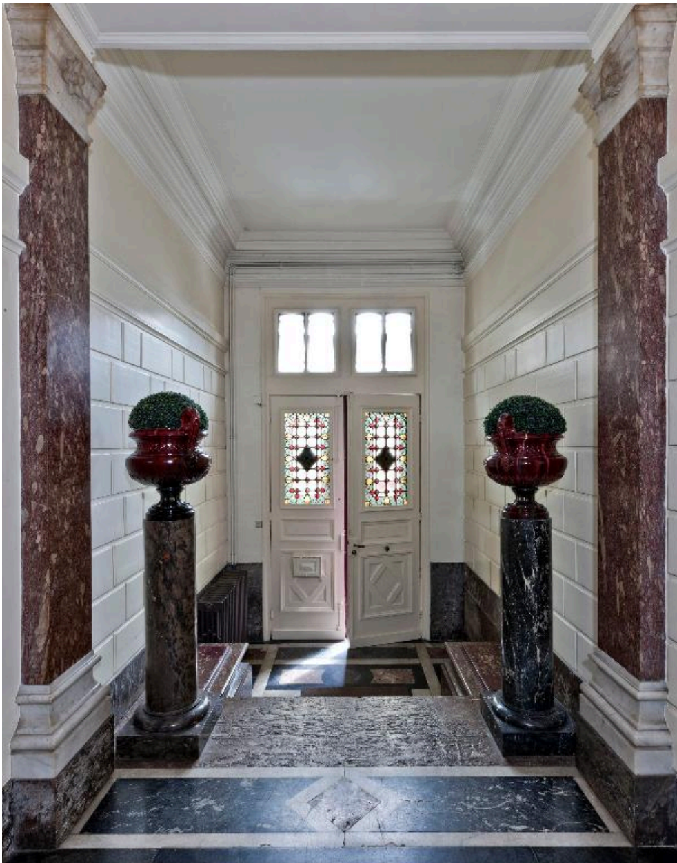
Porte d'entrée : vue d'ensemble.
