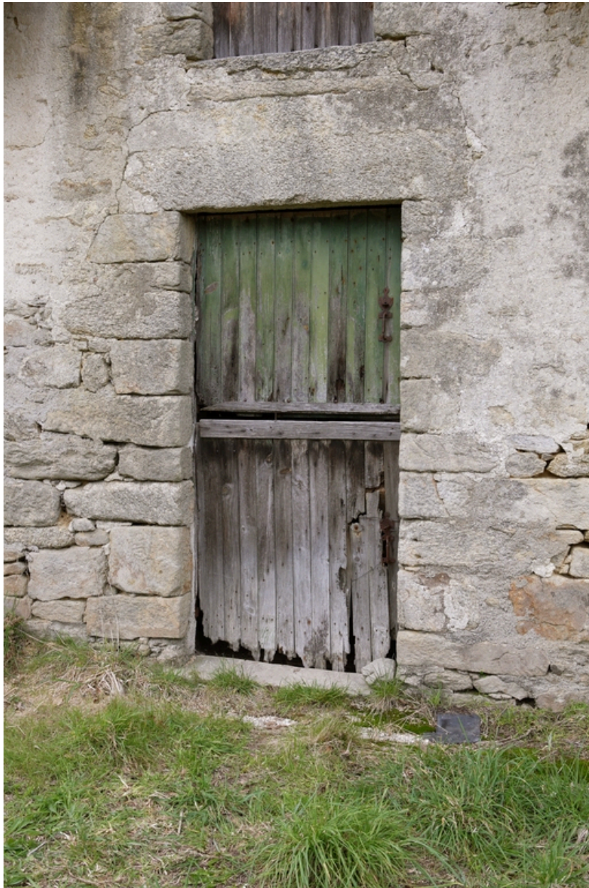
Détail de la porte du 1er logis.
