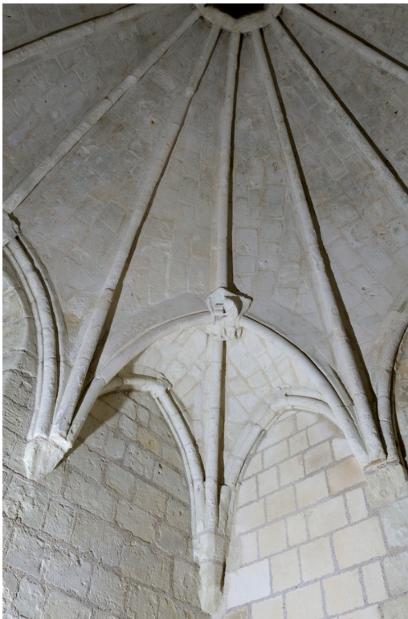
Chapelle haute, voûte, angle sud-ouest.
