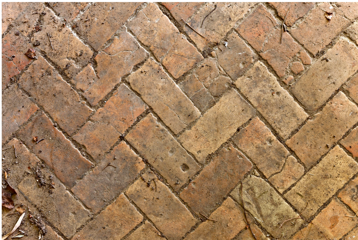
Détail du pavement en briques de la remise.
