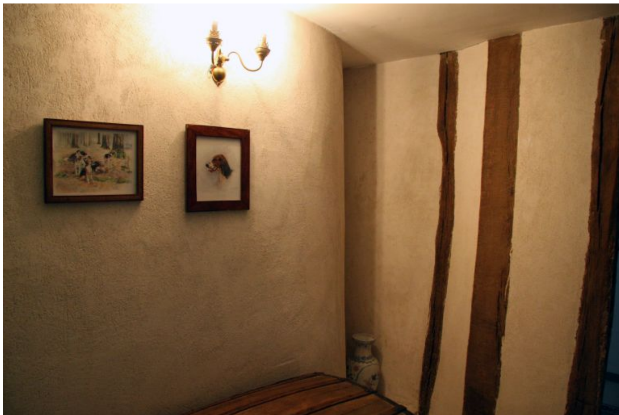
Le logis, 1er étage : cloison postérieure en pan-de-bois.
