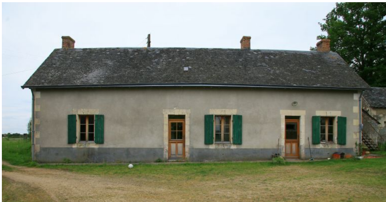
La maison : façade antérieure sur cour.
